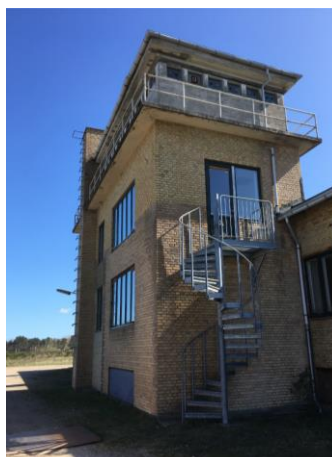
Radiostationens bygninger har stået ubenyttet hen siden radiostationen lukkede i 2009. Fotos: Birgitte Ingrisch
