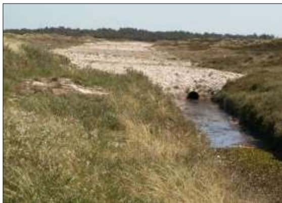
Figur 5. Rørlægning af en del af afløbsgrøften fra Henne Stand er her netop gennemført.
