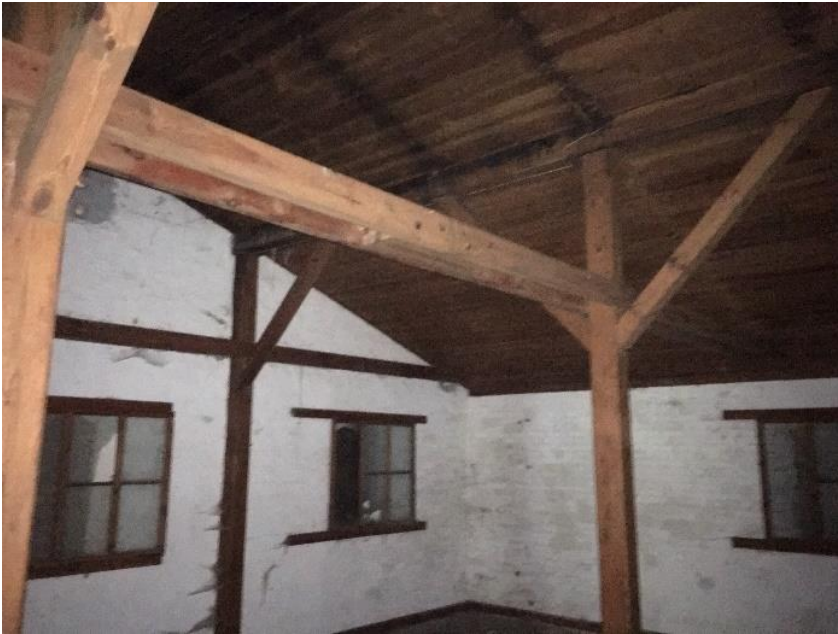
Figur 9. Krudtmagasinet har tykke mure og bræddeloft, så en eksplosion ville forplante sig opad.
