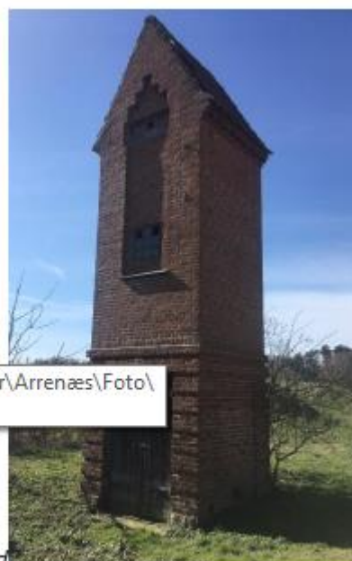
Figur 10. Transformertårnet ved Dronningholm.
